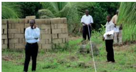
Beginn der Bauarbeiten © Fastenaktion
